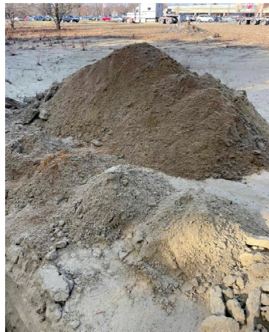
T-3 spoils pile
