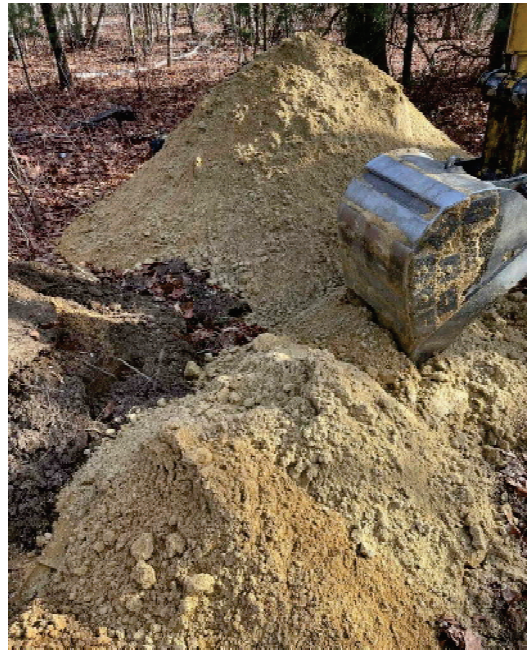
T-4 spoils pile
