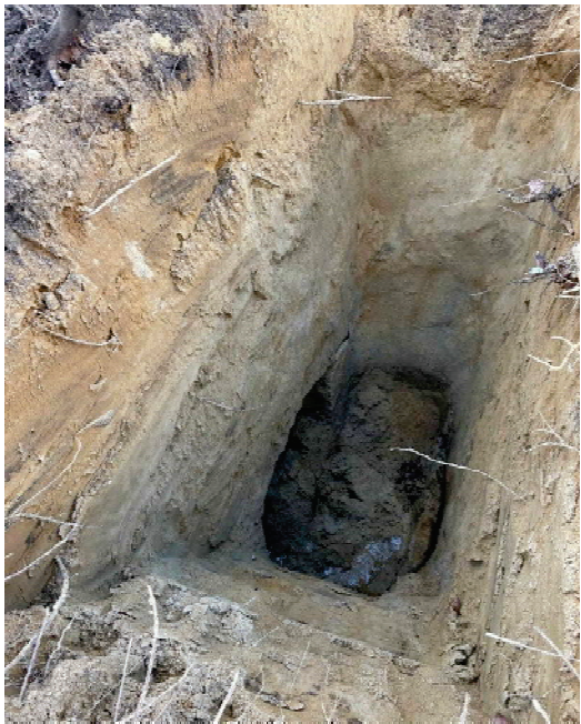
T-2 side wall
