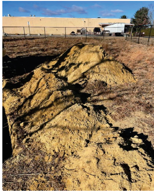
T-5 spoils pile
